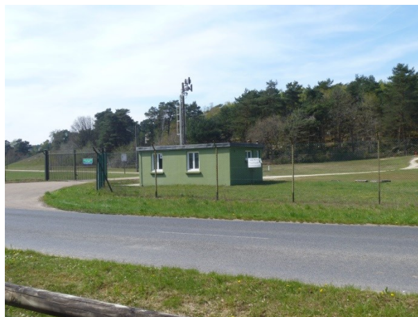
Zone de stockage d'hydrocarbures
